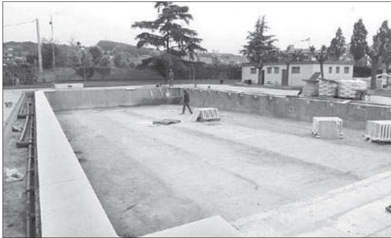
La reforma permetrà reduir la profunditat de la piscina i, a la vegada, millorar la impermeabilitat per evitar les fuites
