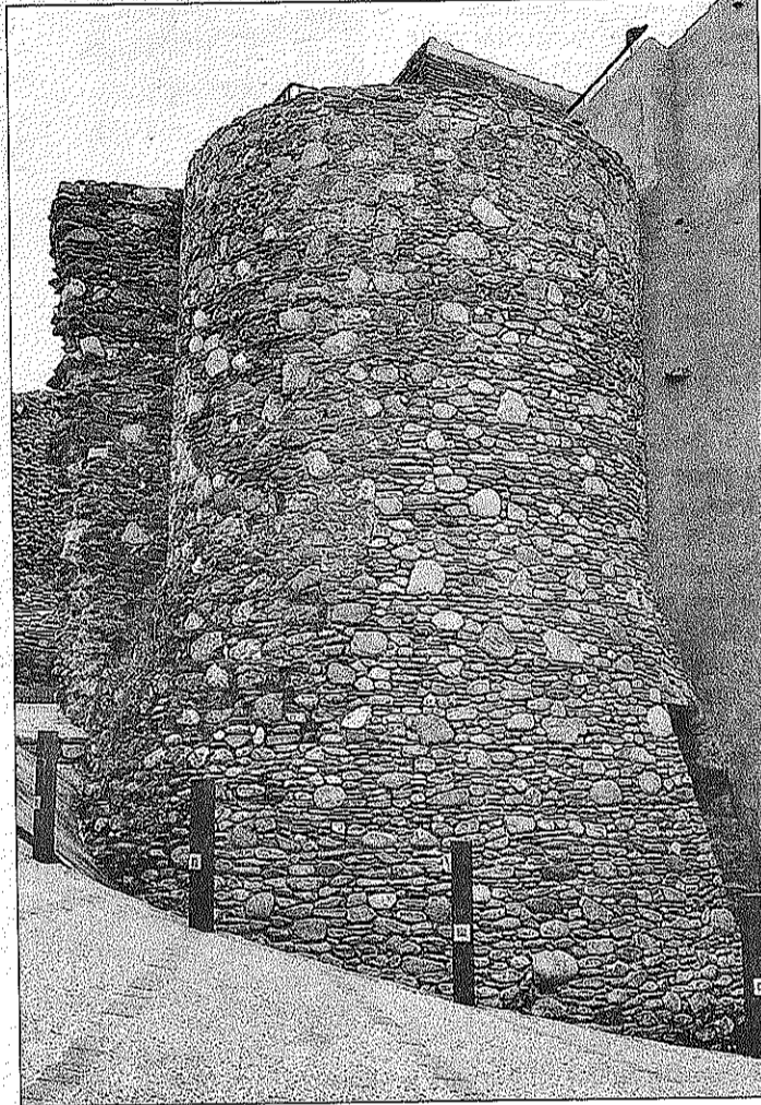
Al 2006 l'Ajuntament ja va recuperar una part de la muralla de La Força
