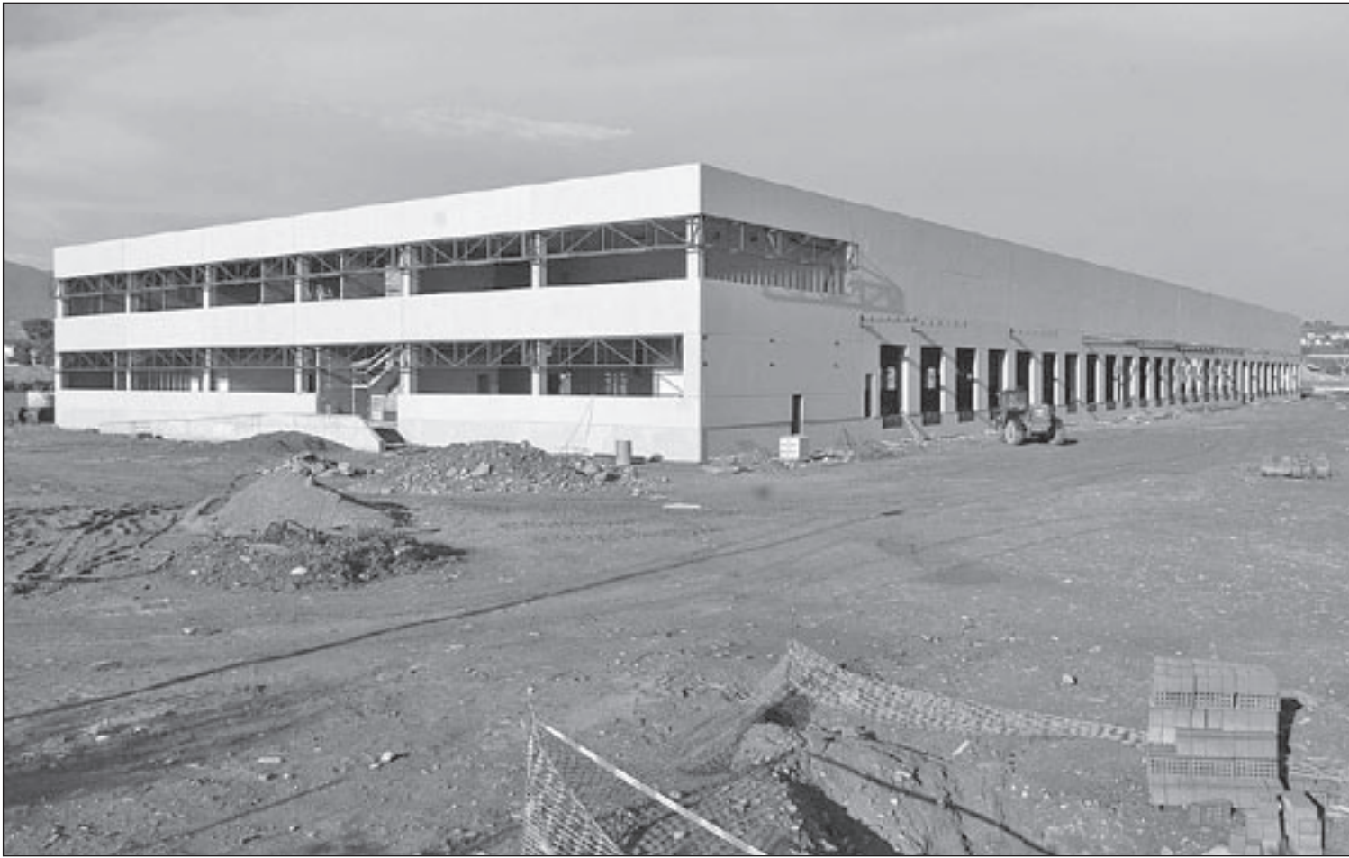
El futur centre logístic de Norbert Dentressangle s'està fent al carrer Itàlia del polígon industrial del Pla de Llerona
