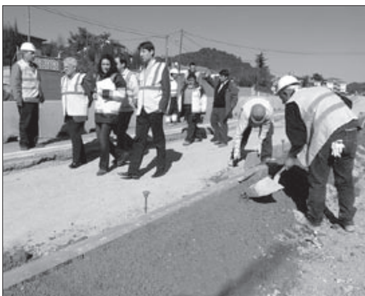
L'alcalde Jordi Solé durant la visita a les obres d'aquest dijous al migdia
