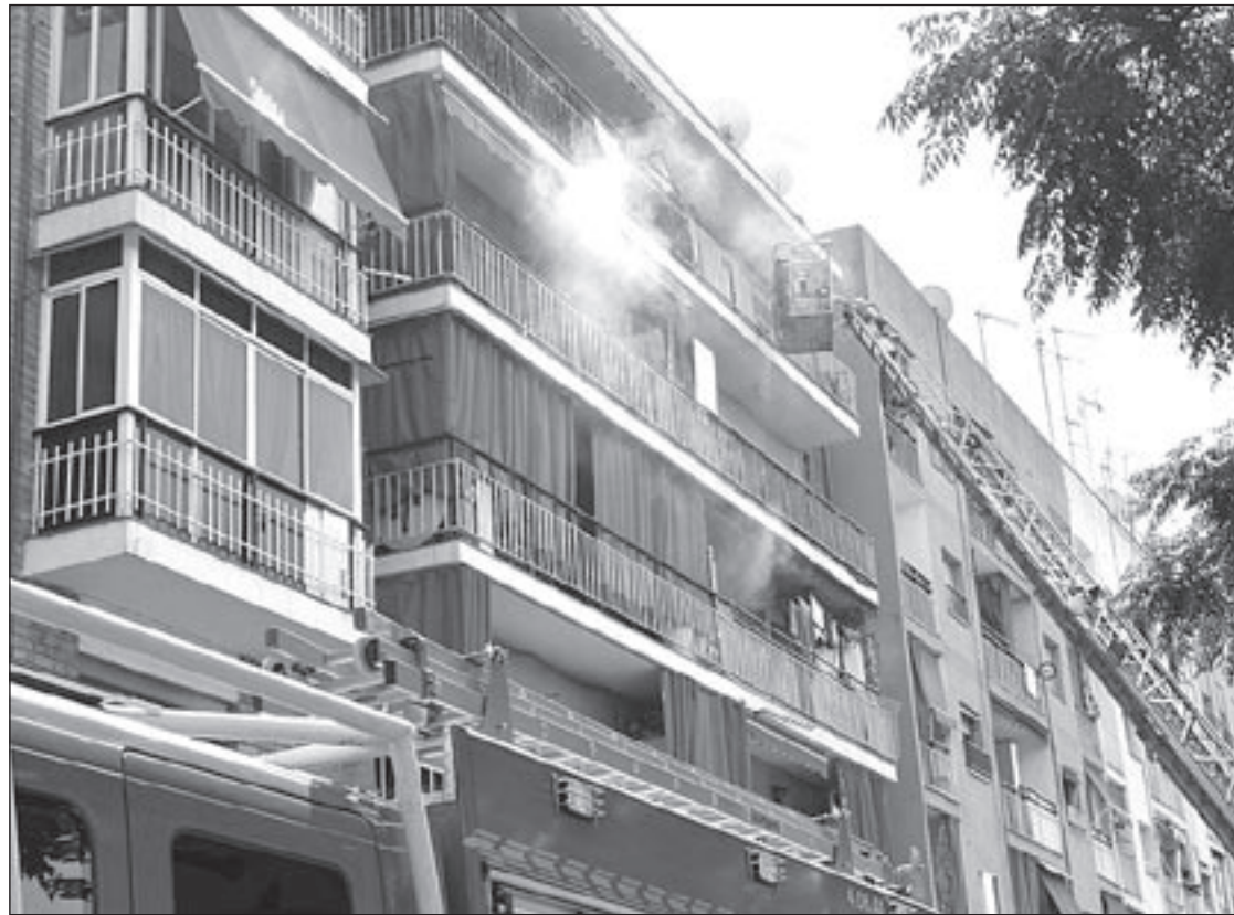
Una imatge de l'edifici del carrer Aragó de Bellavista durant l'actuació dels Bombers, aquest dimarts
