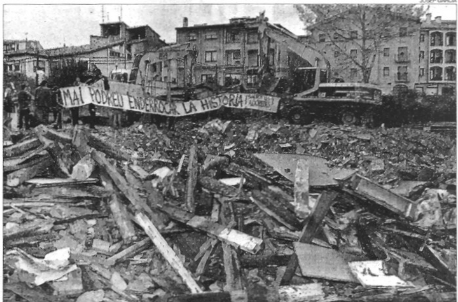
►► Manifestants a la zona dels enderrocs de les Adoberies de Vic, ahir.
