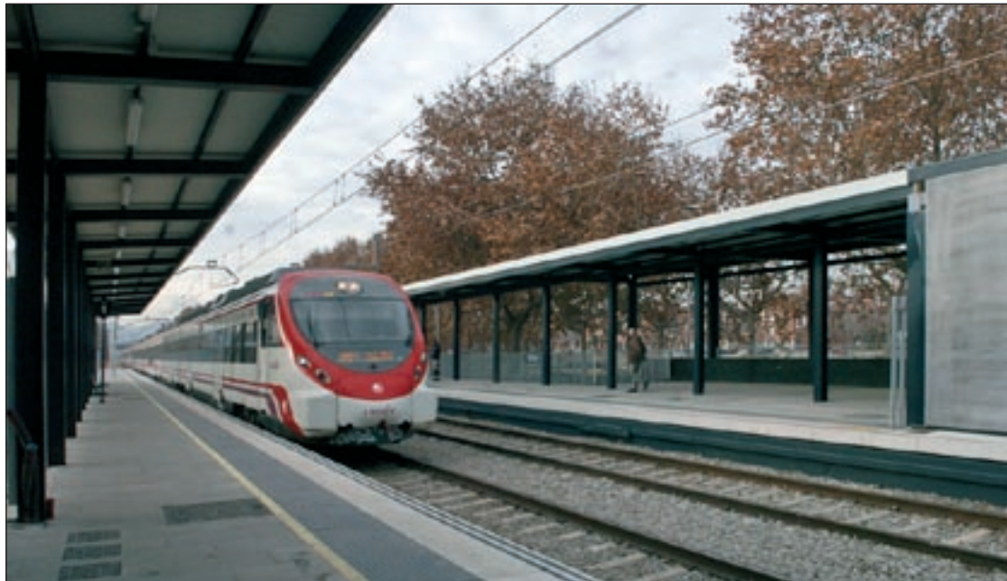
L'estació de tren de la Llagosta ja compta amb unes andanes més llargues i un nou edifici per als viatgers
