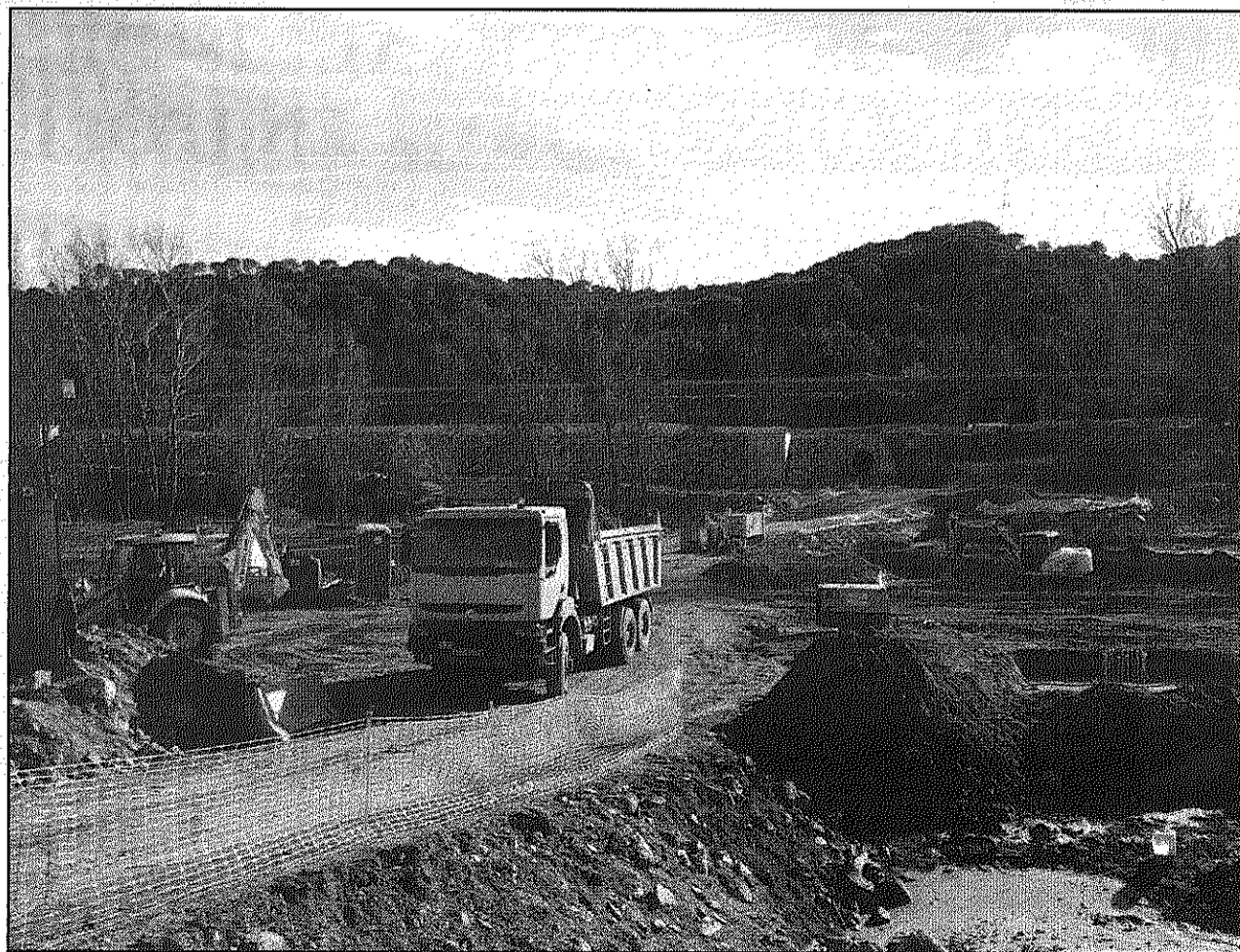
Una imatge dels treballs de construcció del pont sobre el riu Tordera iniciades fa uns dies a la Batllòria (AdBM)
