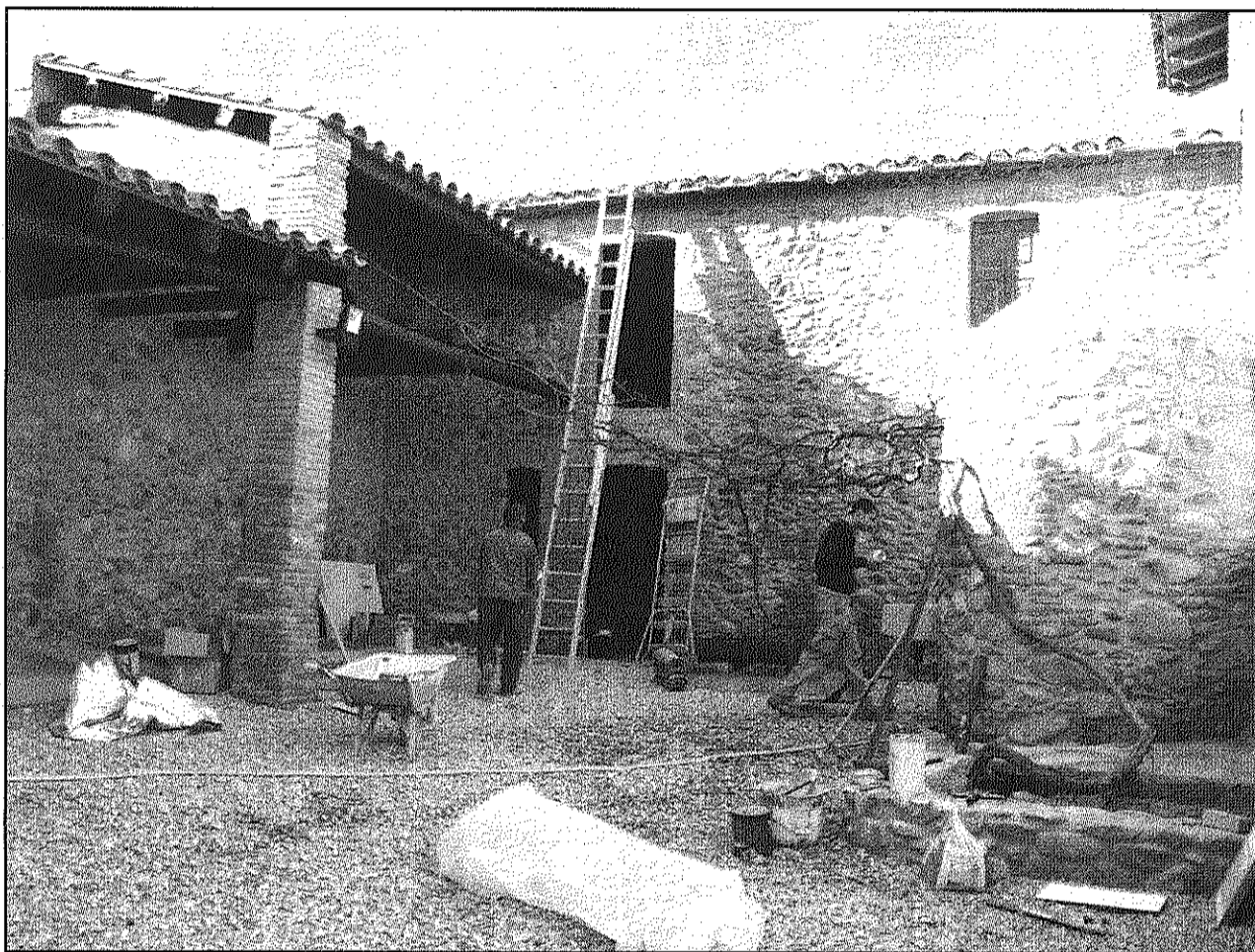
Els treballs han inclòs la recuperació del pati d'aquest edifici cèntric de la població (AdBM)
