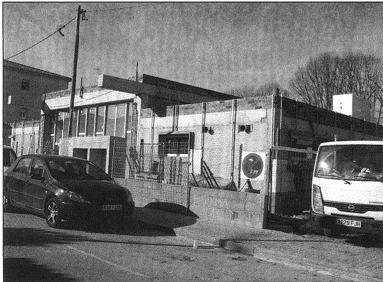
L'estructura del nou edifici ja està enllestida i resten per acabar alguns detalls i les instal·lacions (AdBM)
