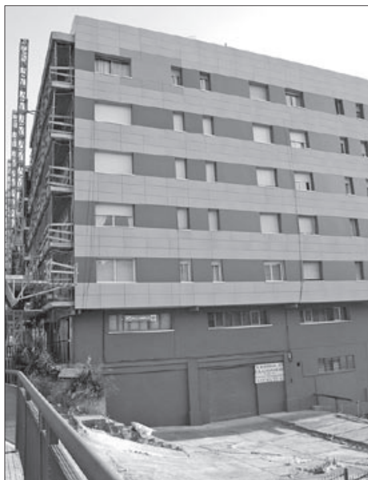
Una de les façanes dels pisos de Cal Tiana
