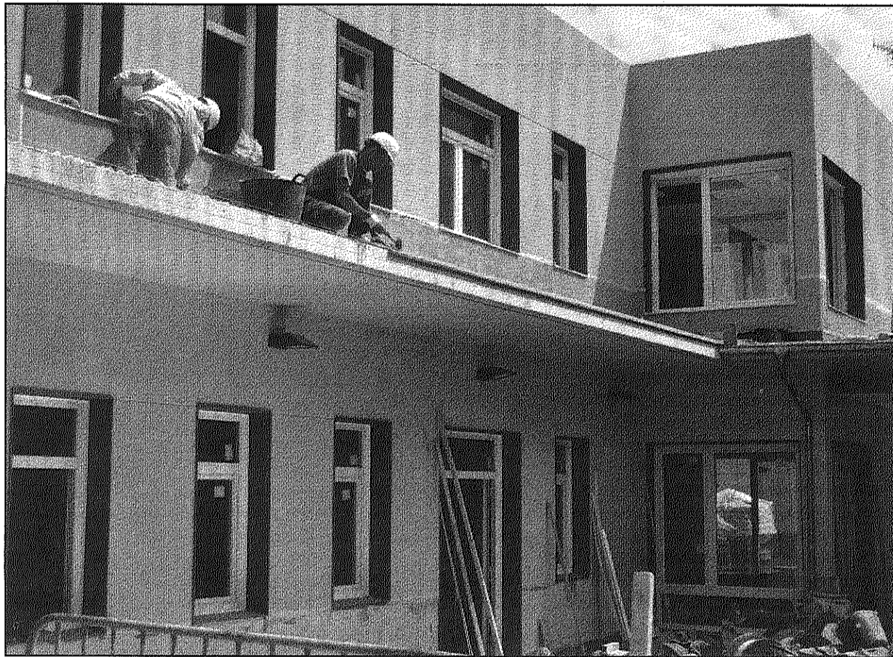
S'estan ultimant els treballs als espais rehabilitats de Can Ramis per a la seva obertura per Sant Jordi (A4BM)
