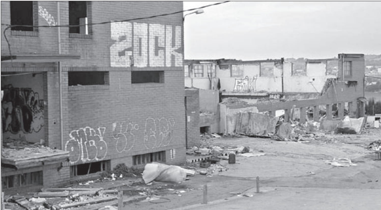
Les naus de l'antiga empresa Lacats Sam estan mig derruïdes per l'acció de recollidors incontrolats de ferralla
