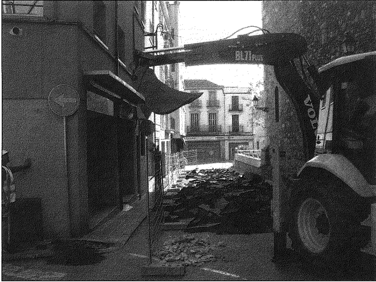
El paviment del carrer Abat Oliba s'ha començat a aixecar per les obres de millora del carrer (AdBM)
