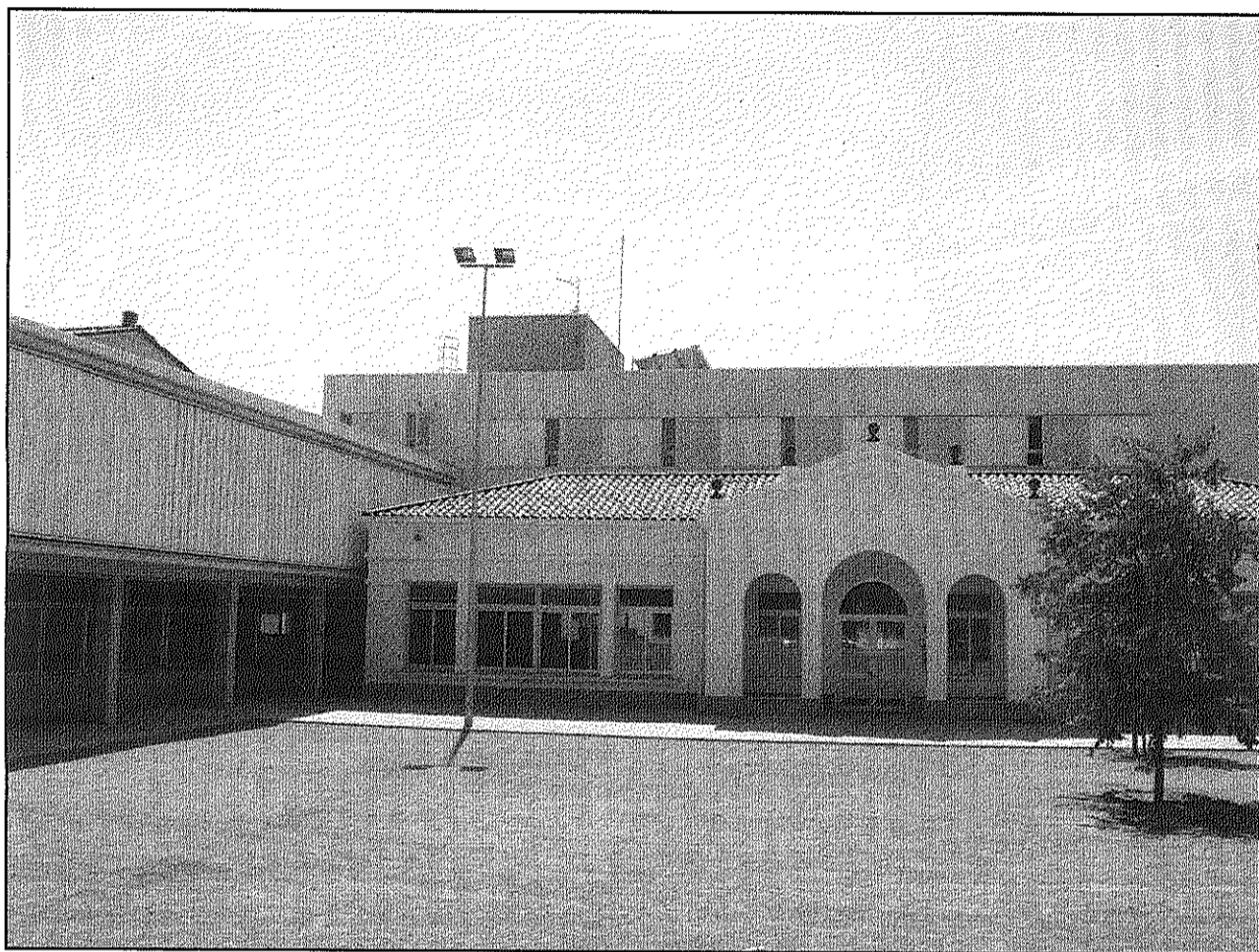
L'escola Montnegre ha finalitzat les obres de construcció del nou aulari que obrirà el curs vinent (AdBM)
