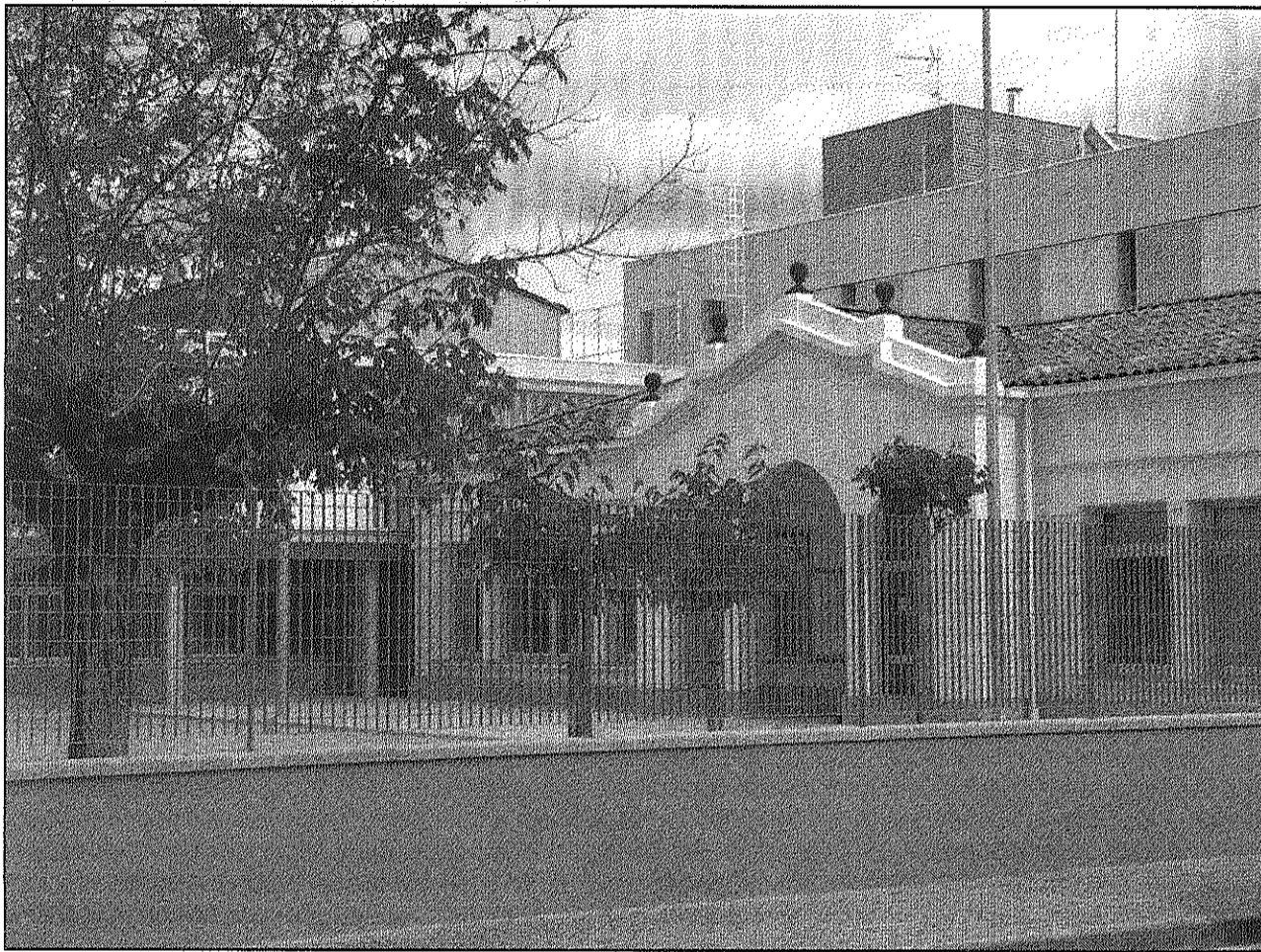
L'escola de la Batllòria ha obert portes amb l'estrena del edifici i amb prop de 180 alumnes inscrits (AdBM)
