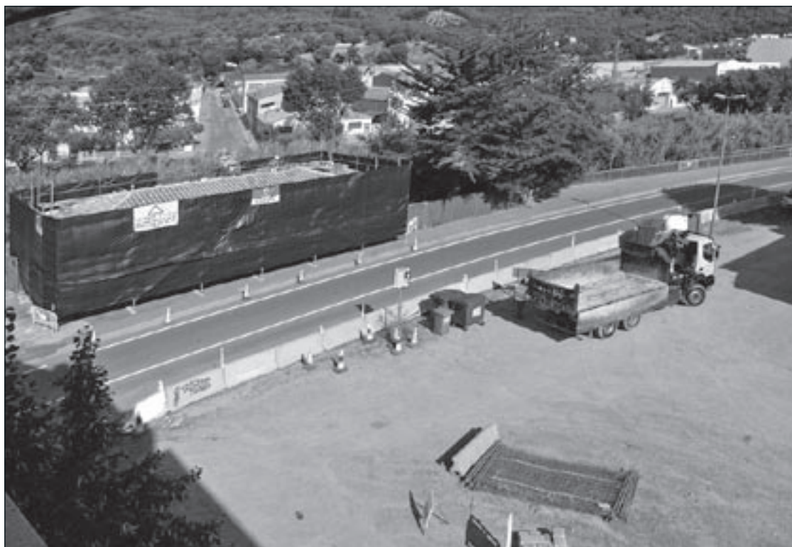
Els safareigs de l'arquitecte Raspall tapats del tot aquesta setmana per les obres de restauració
