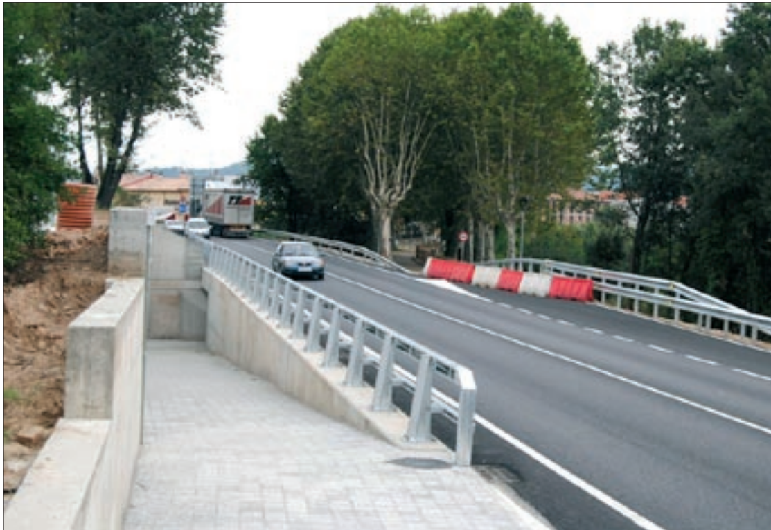
El pas inferior, situat a prop de l'empresa tèxtil Inacsa, dona seguretat a l'hora de creuar la C-35
