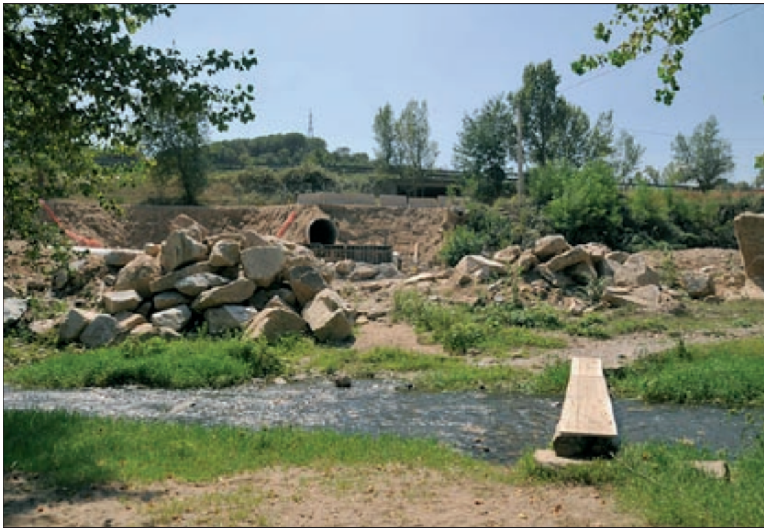
El pas actual, completament provisional, serà substituït per un pont amb capacitat per absorbir trànsit i vianants
