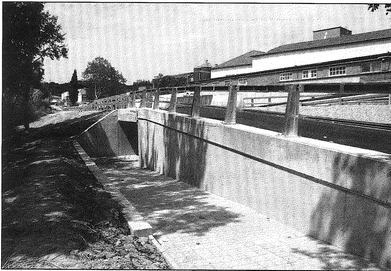
El nou pas soterrat ja ha s'ha obert als vianants i falta permetre al trànsit accedir a la carretera Vella (AdBM)
