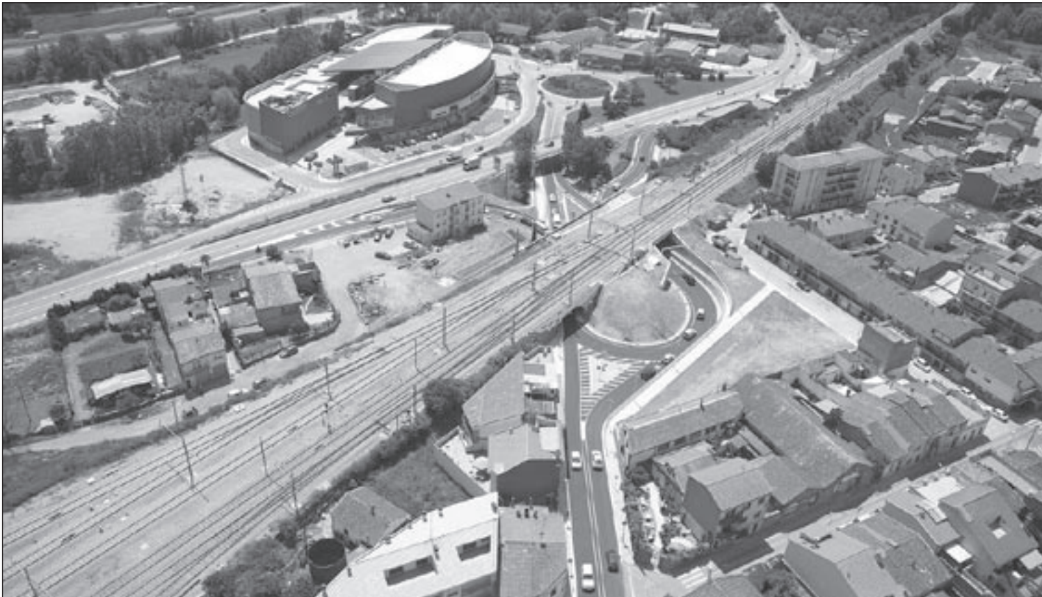
La nova entrada per la porta de ponent té dos ponts sota el ferrocarril que faciliten l'accés al poble i al centre comercial, a la part superior de la imatge
