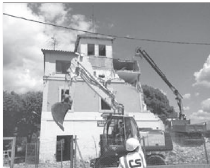
L'edifici de l'antiga escola Moncanut s'ha enderrocat aquesta setmana
