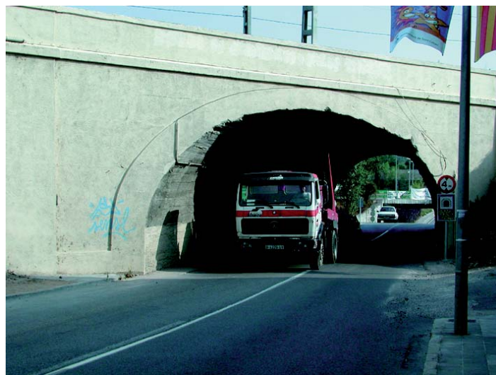
D'aquí a pocs dies es podrien reprendre les obres del nou túnel (FOTO: arxiu la Vila)
