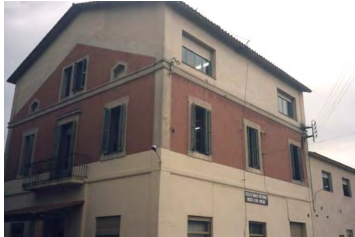
L'edifici de l'antiga escola de formació professional, Alfons Montcanut serà derruït per construir el futur centre de dia (FOTO: P&P)
