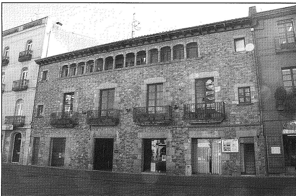
Es netejarà tota la façana i es reposaran les juntures trencades a la part frontal de l'edifici (L'ADBM)
