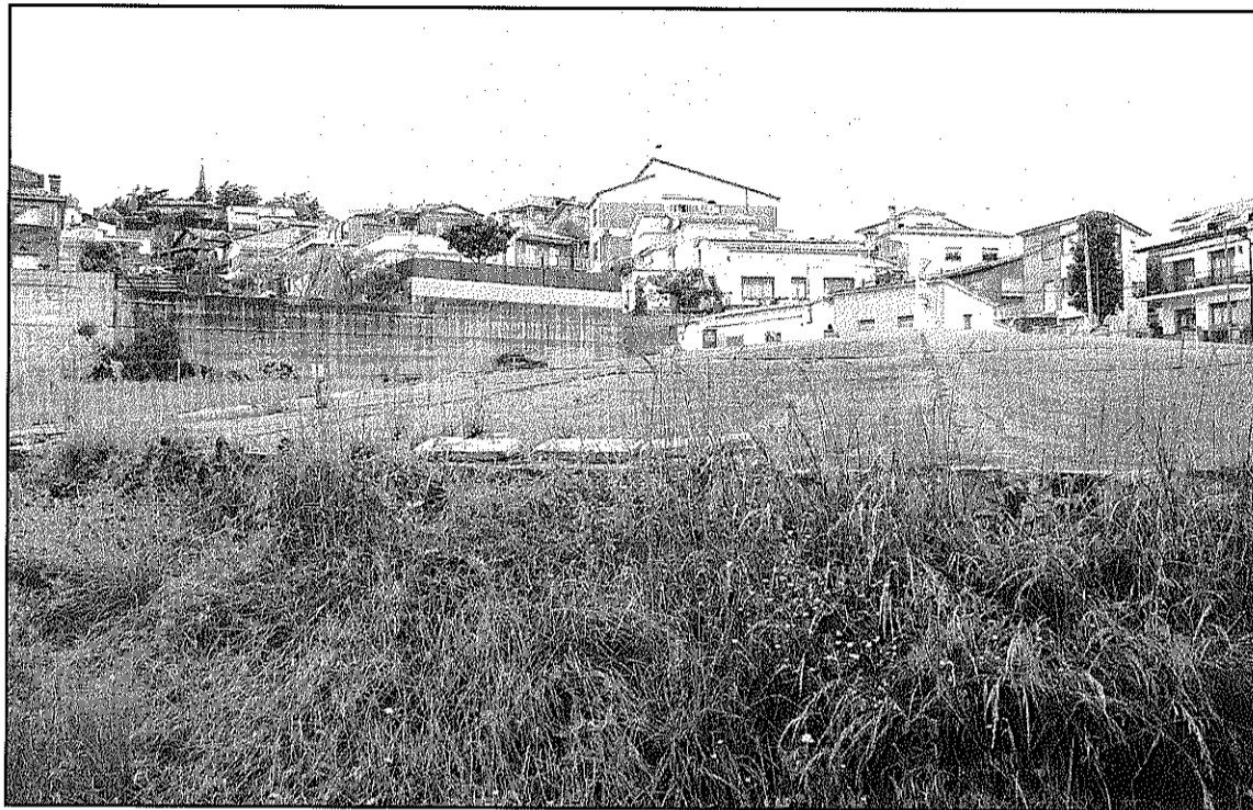
L'espai que actualment ocupa el dipòsit de la Salle es destinarà a aparcament descobert (L'AdBM)
