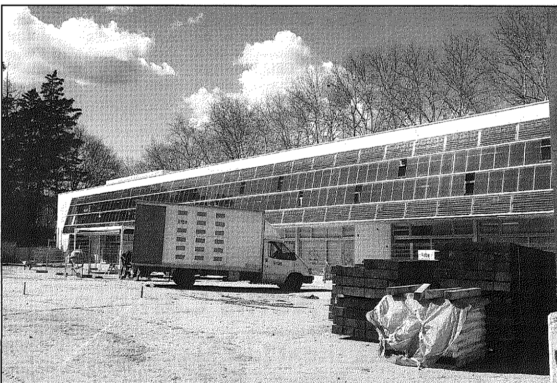
L'empresa adjudicatària ja ha començat a treballar en l'adequació del pati del Blauet (L'AdBM)
