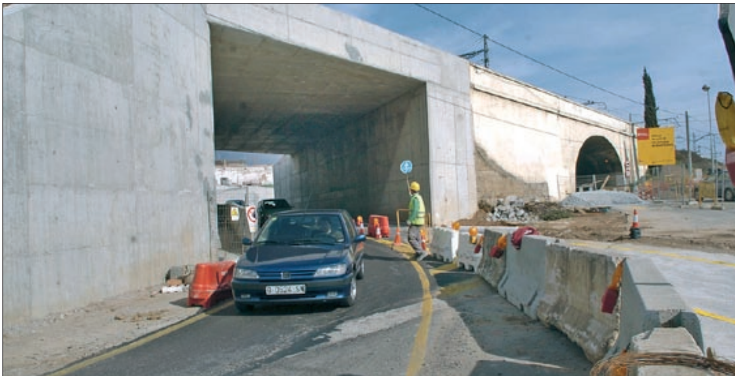
Des de la setmana passada, els vehicles circulen pel nou túnel sota la via del tren de la porta de Ponent de Sant Celoni
