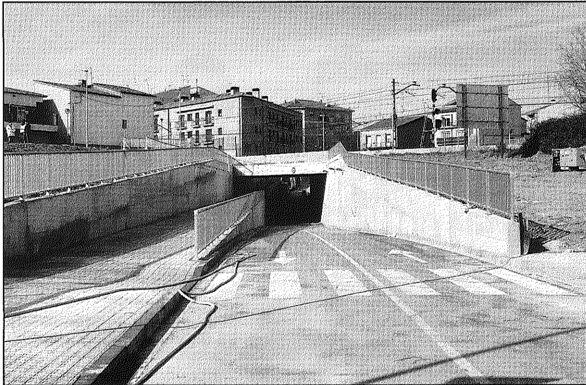
Una imatge del pas sota la via aquesta setmana, després que hagin finalitzat les obres (L'ADBM)
