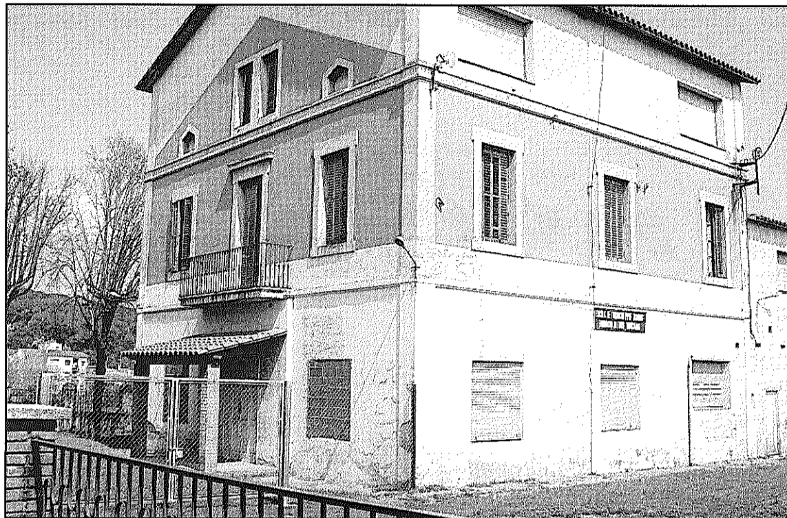
L'actual edifici s'enderrocarà per construir un equipament d'una planta ampliable a dues (L'AdBM)
