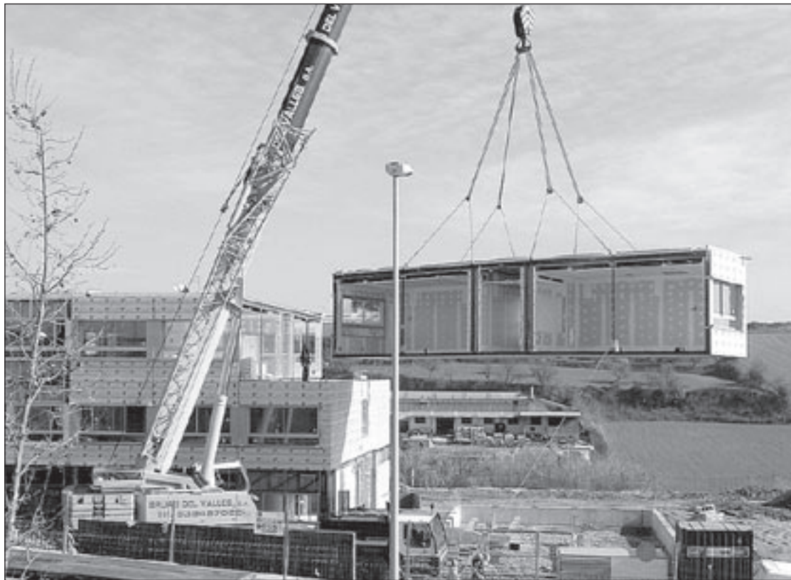
Nous mòduls prefabricats a l'escola Colors de Bellavista
