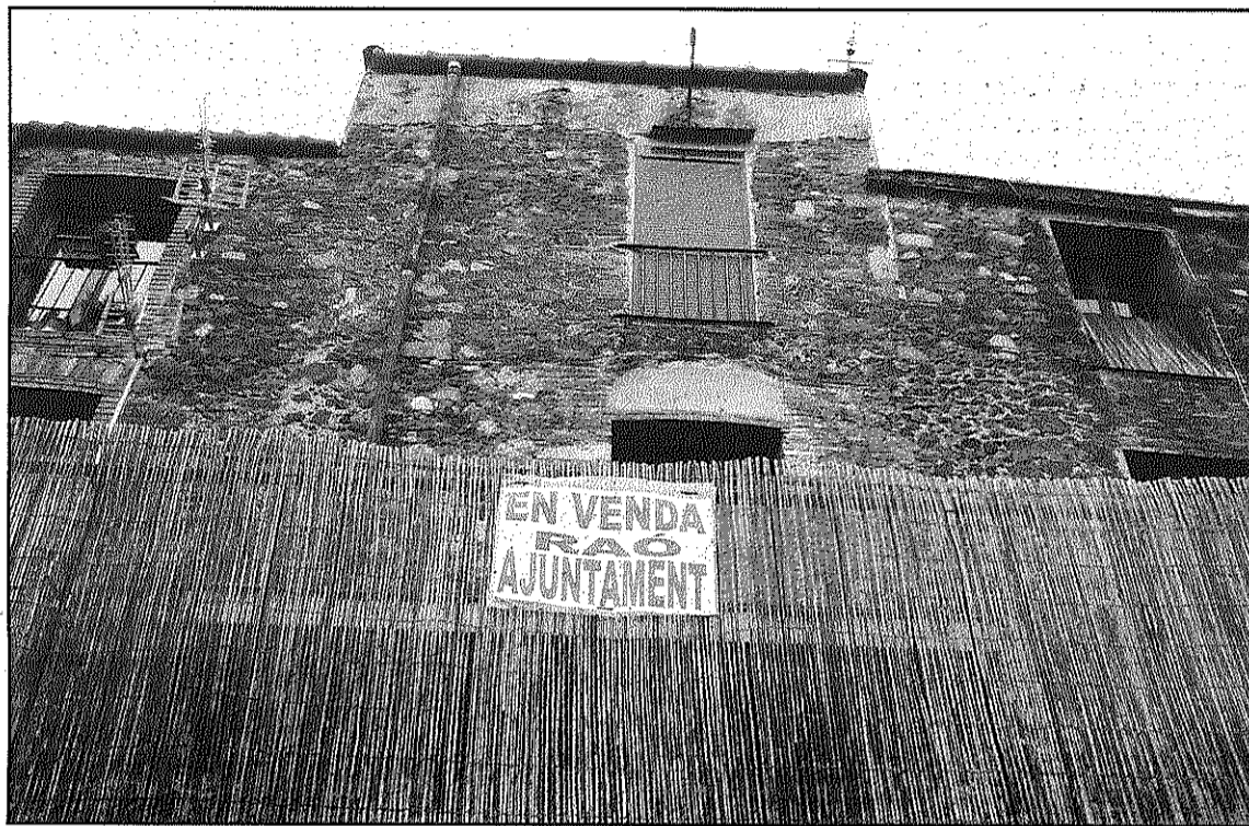
Un part dels veïns segueixen disconformes amb el pla de recuperació del pany de muralla (L'AdBM)
