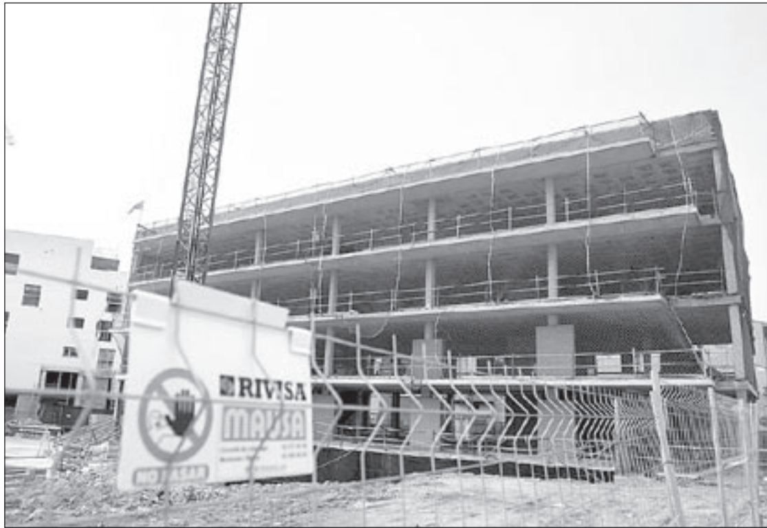
L'estructura de l'edifici protegit de Can Comas està feta però hi ha pendents totes les façanes i tots els interiors
