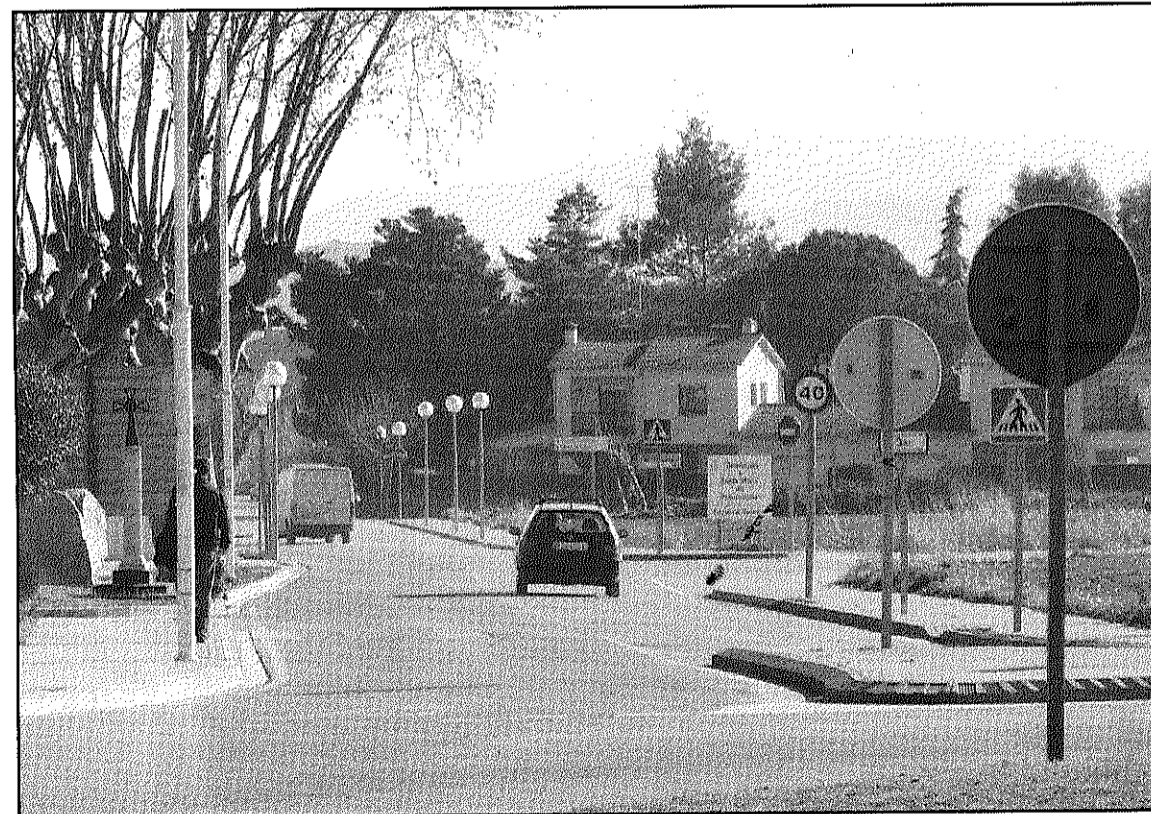
La carretera Nova de Sant Esteve comptarà amb un carril bici després de les obres (L'AdBM)
