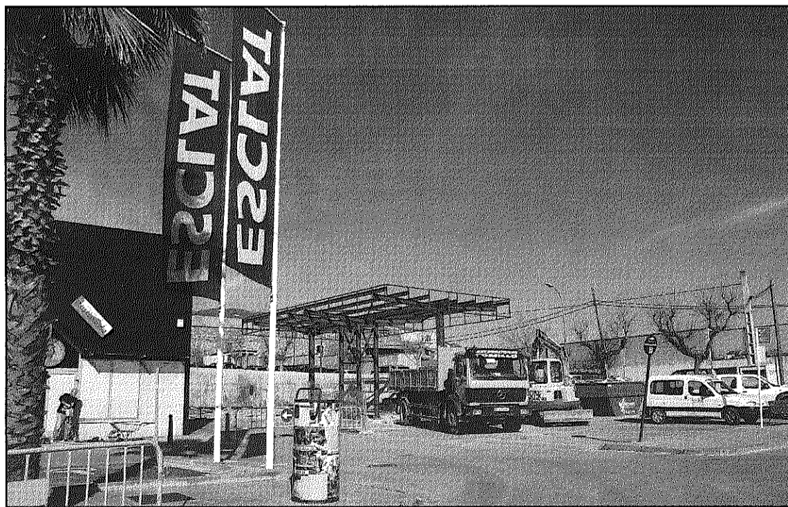
Una imatge de les obres que s'estan fent a l'hipermercat Esclat de Sant Celoni (L'AdBM)
