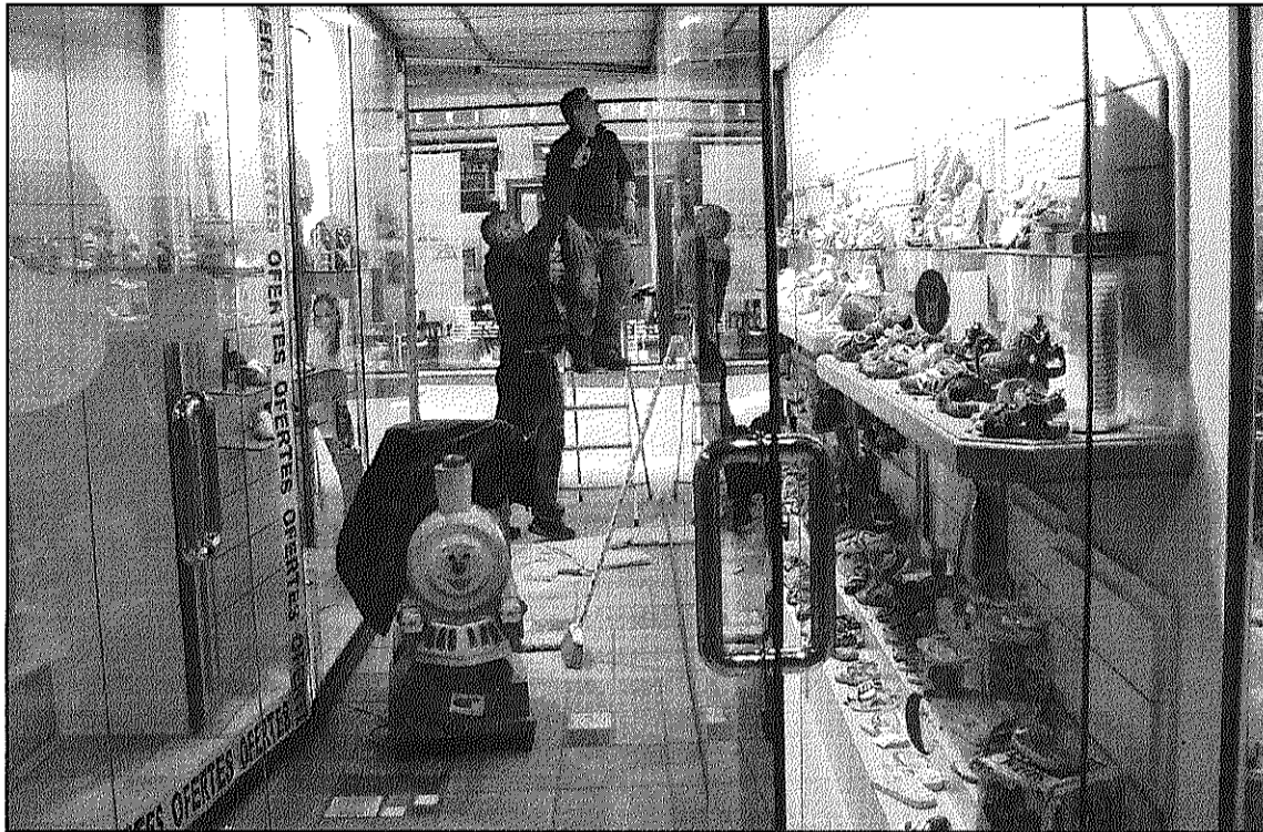
Uns treballadors reparaven dijous els plafons malmesos del sostre (L'AdBM)
