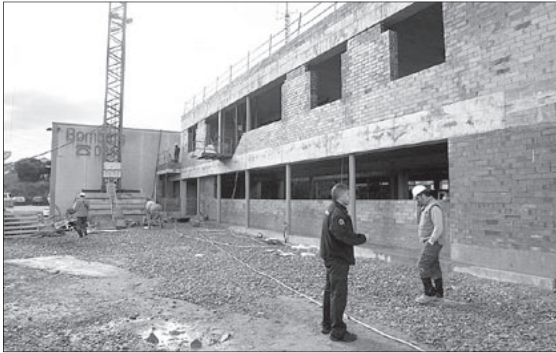
El proper mes de març acabarà la primera part de les obres d'ampliació del parc
