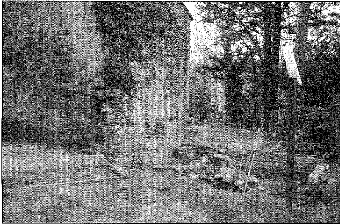
Imatge d'un dels fanals trencats i les tanques destrossades a les excavacions de la Rectoria (L'AdBM)
