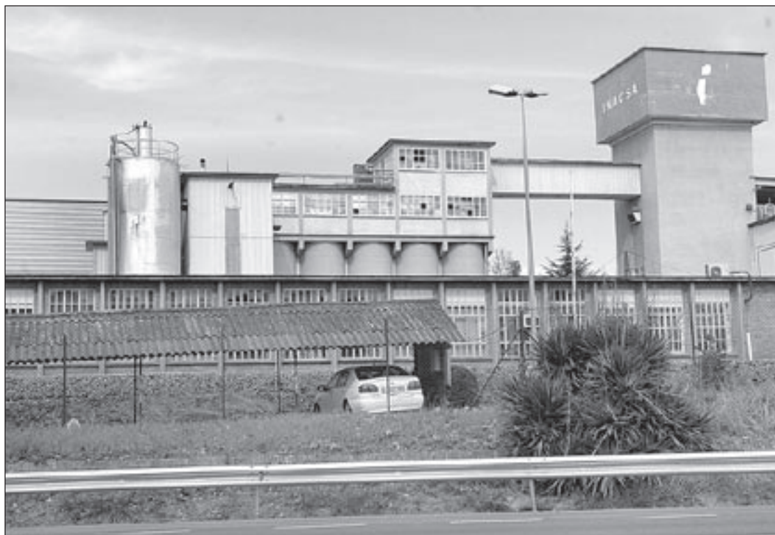
La fàbrica de l'empresa tèxtil està situada a la Batllòria, en terme municipal de Sant Celoni
