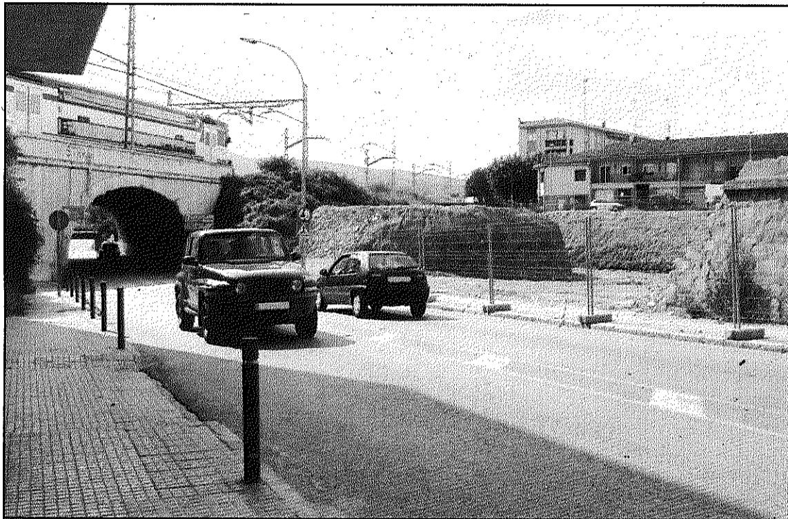
Les obres de construcció del nou accés al municipi fa mesos que romanen aturades (L'ACBM)
