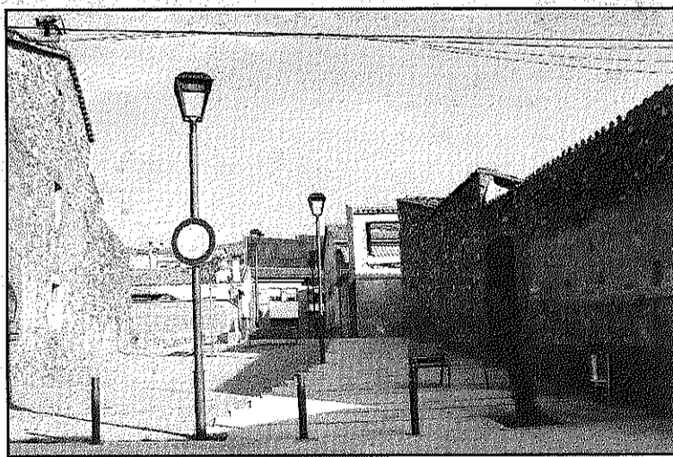
Una imatge del carrer Breda amb les obres acabades (L'AdBM)
