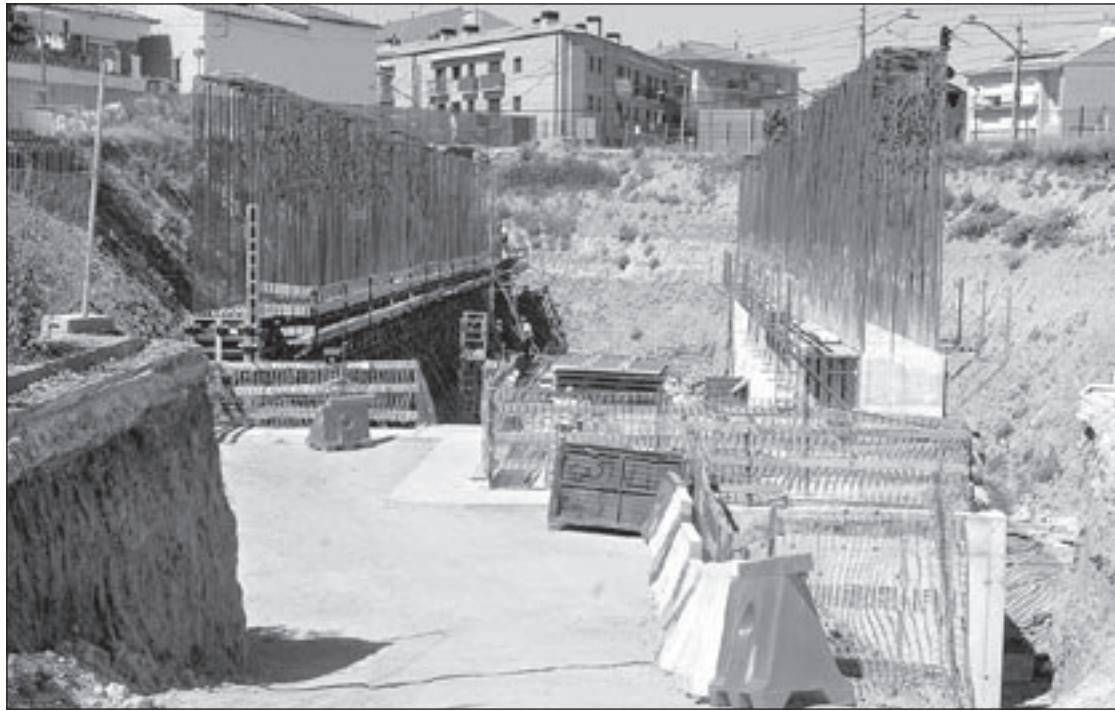
Les obres del pas a nivell que s'està suprimint al carrer Roger de Flor ja són visibles
