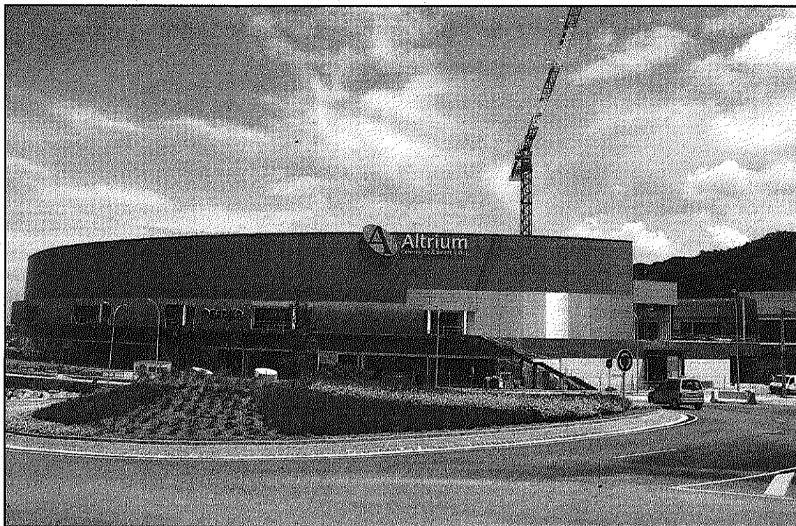
L'Altrium de Sant Celoni ja compta al sostre amb plaques fotovoltaïques (L'AdBM)
