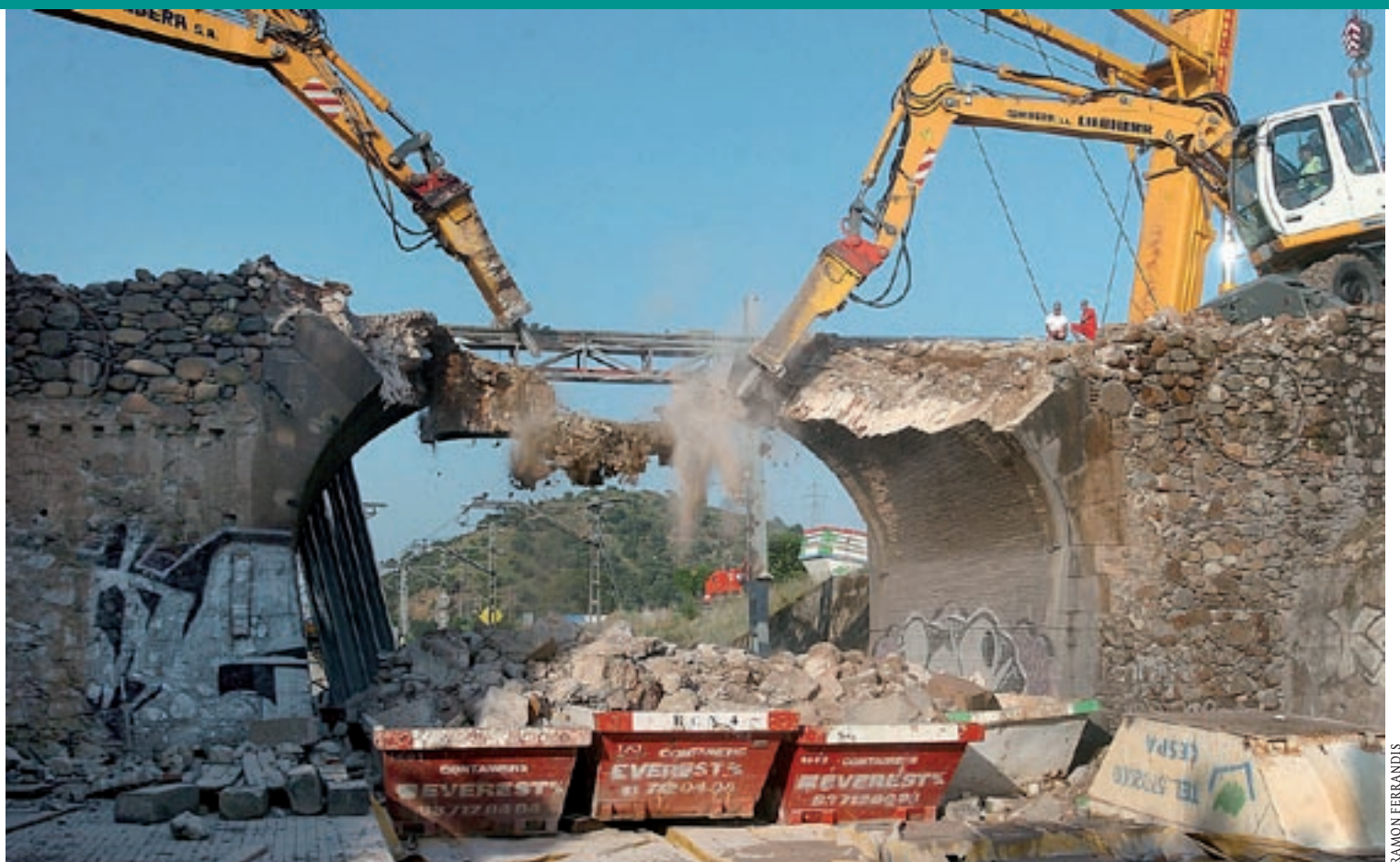
Dues màquines en ple enderroc del pont sobre les vies de tren a Montmeló, aquest dissabte
