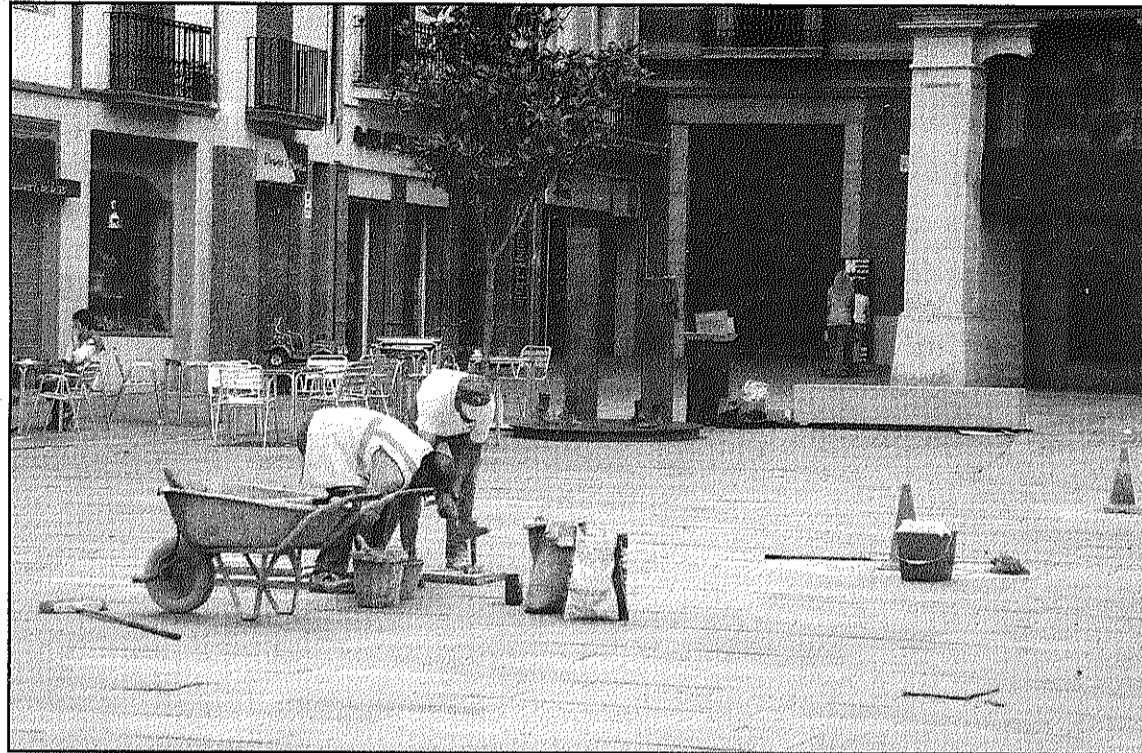
Uns operaris a la plaça de la Vila, aquest dimecres al migdia (L'ADBM)
