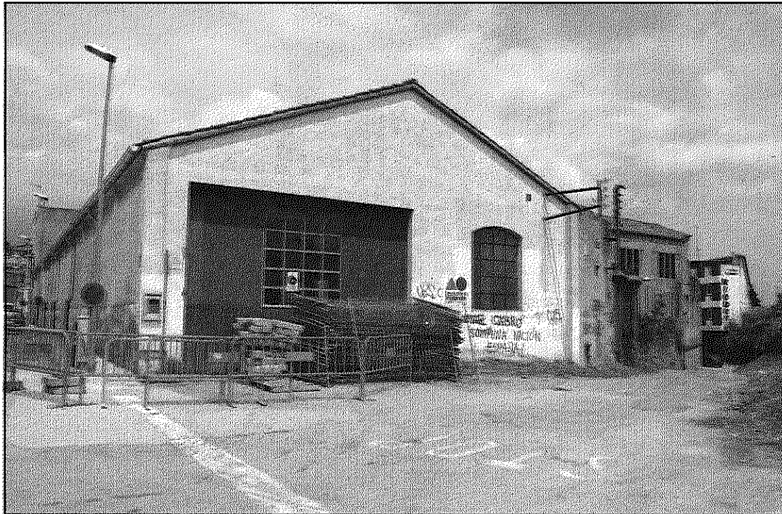
L'empresa ja ha iniciat els preparatius per a l'enderroc de la nau (L'AdBM)
