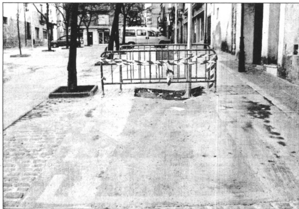
Com les "Cares de Bémez", un fenomen paranormal fa aparèixer de terra zones blaves abans d'acabar-se les obres (L'AIMBM)
