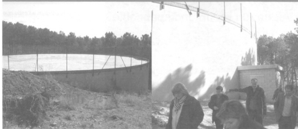
El nou dipòsit del Turó, amb capacitat per a 4.500 metres cúbics d'aigua
