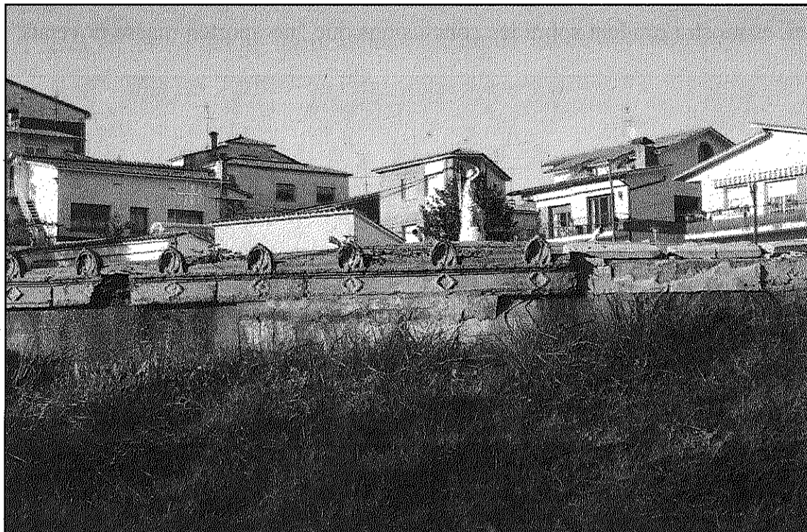
L'adjudicació implicarà la millora de les instal·lacions de subministrament d'aigua (L'AGBM)
