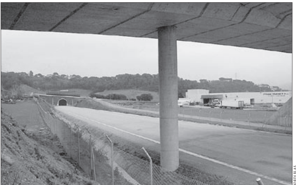
La plataforma del TAV per sota de la carretera de Palautordera a Sant Celoni. L'obra està gairebé acabada
