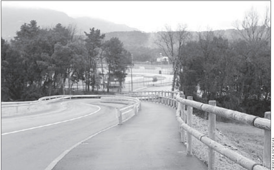
Els accessos a l'institut de Sant Celoni ja s'han arreglat però encara no tenen els fanals per il·luminar-los de nit
