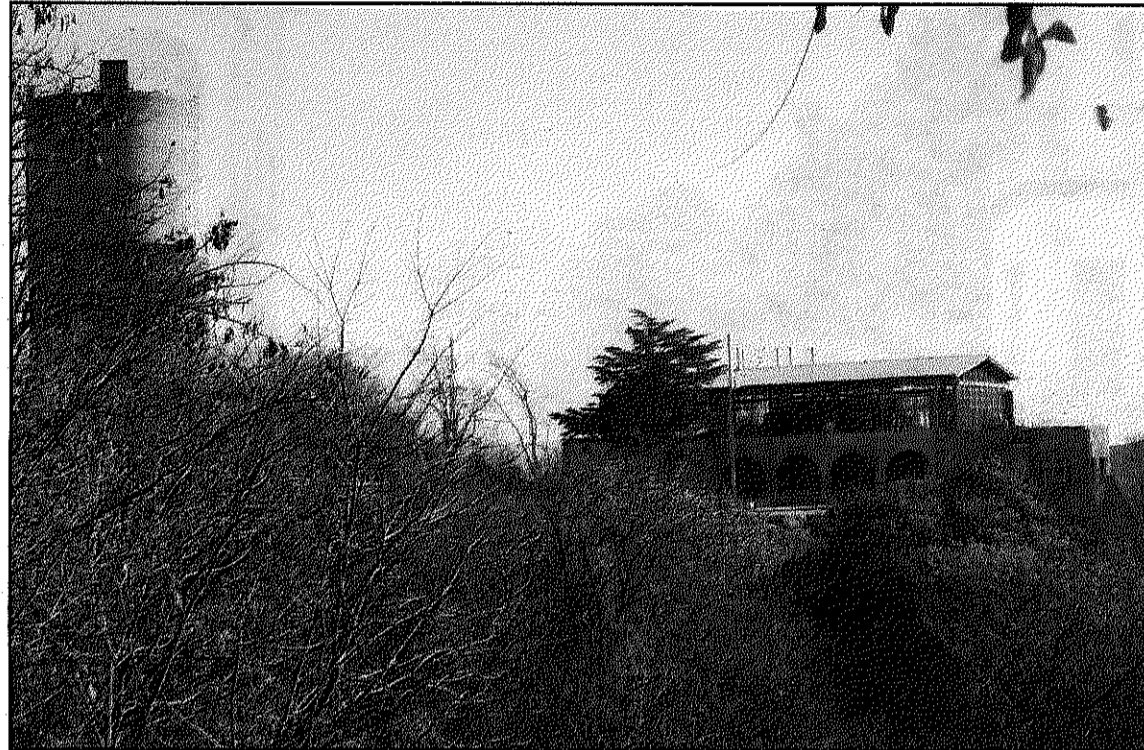
L'Ajuntament ampliarà i reformarà el camí des de Can Llensa fins al portal de les Hortes (L'ADBM)
